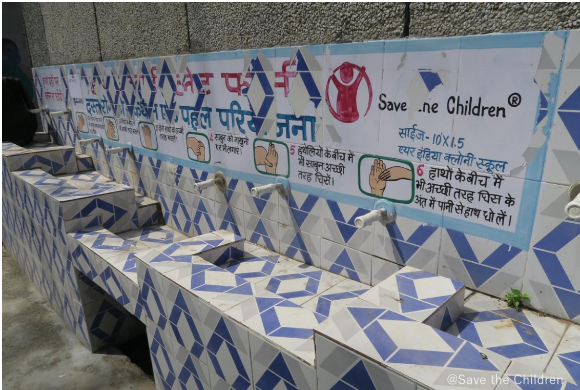
現地小学校の水道
